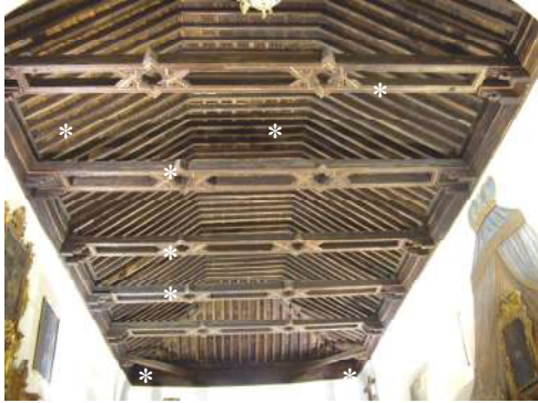
Armadura del Lugar Alto.
