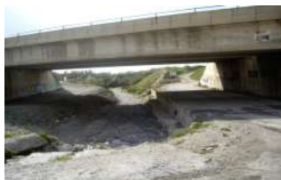
Puente de la autovía.
