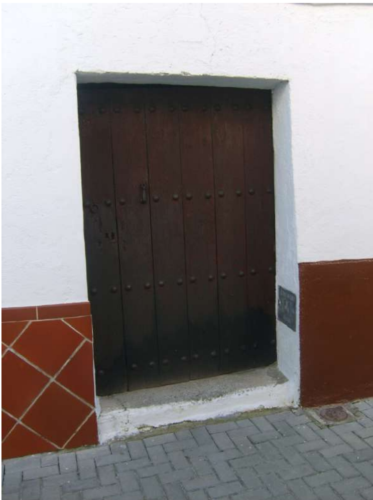
Preciosa y antigua puerta en la calle Vallejo. Se puede apreciar, a la derecha, la arqueta de registro de agua.
