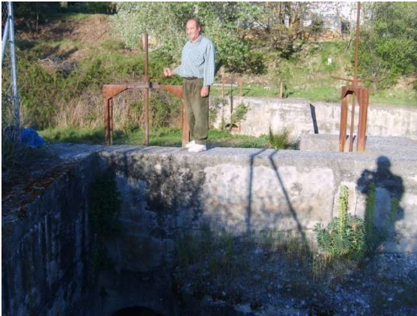
Primera presa que alimenta la Acequia Real de Ogijares. El inicio de la misma está bajo la compuerta que manipula Celestino, el acequero. A la derecha el desarenador.
