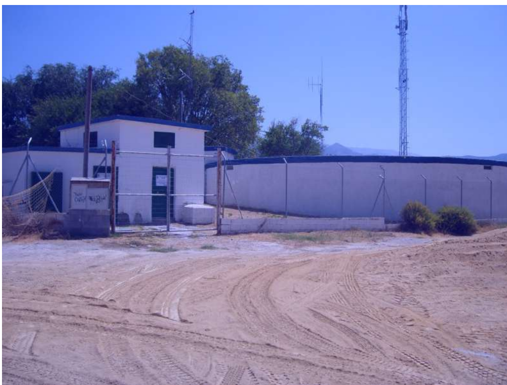
Depósitos de agua en el Cerro de San Cristóbal
