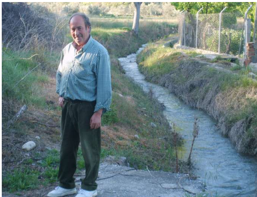
Tramo de la Acequia de Alhacafa. El agua discurre por su cauce sin revestir, tal como lo hacía hace cientos de años.
