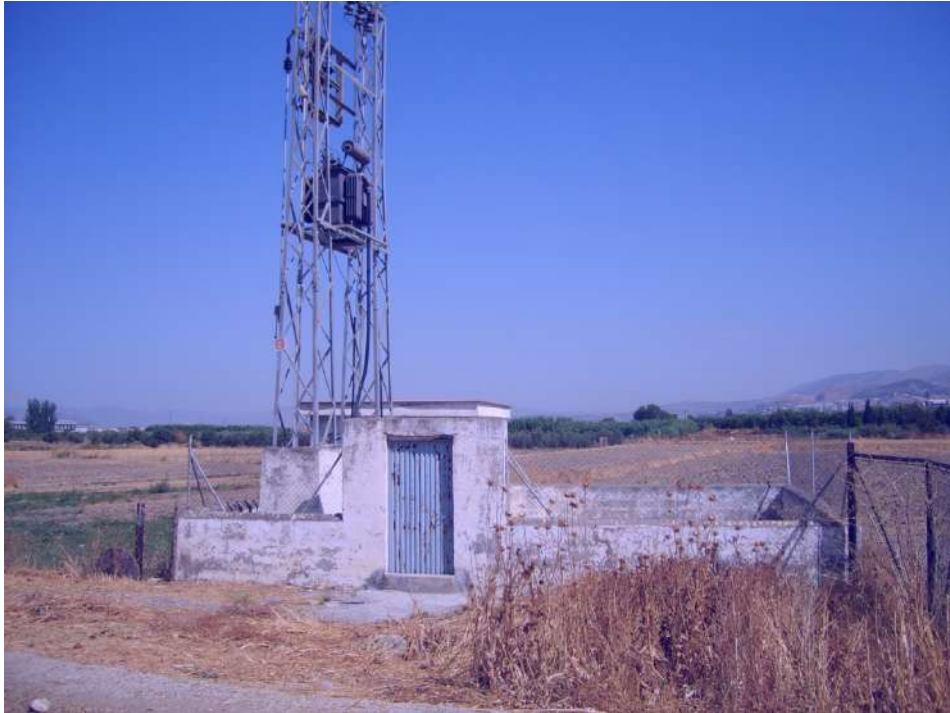
Pozo “San José”, en el pago del Romizal, junto al Ramal de los Charcones.
