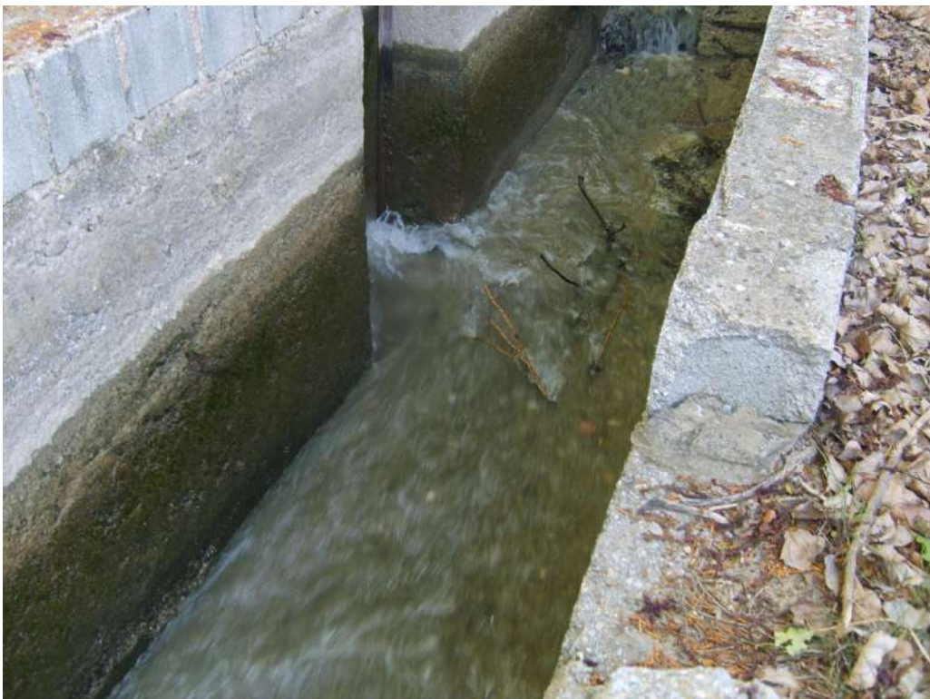
Momento en el que el desarenador hace su eficaz trabajo. Acequia Real.
