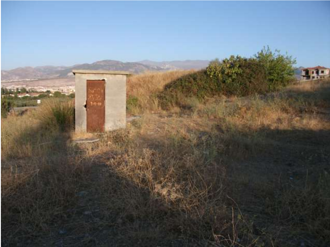
Caseta de registro del agua de La Mina cerca de la actual Autovía y en el paraje de “Las Peñuelas”. Varias como ésta se podían ver a lo largo del recorrido de la conducción.
