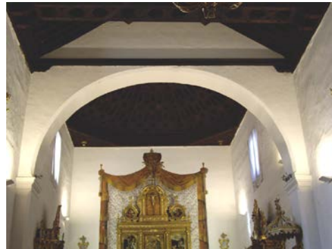
Arco toral del Lugar Alto y del Lugar Bajo, sostenidos por columnas adosadas.
