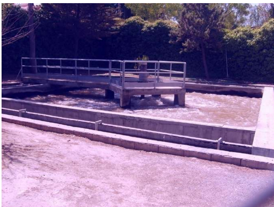
Inadecuado tratamiento de las aguas residuales en Loma Linda junto a la Acequia Real.
