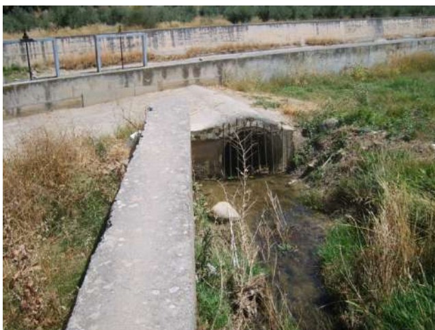
Punto en el que se entuba el agua de la acequia de Alhacafa para evitar la presa en el río Dílar. Pueden verse las compuertas de la nueva acequia de Gabia.
