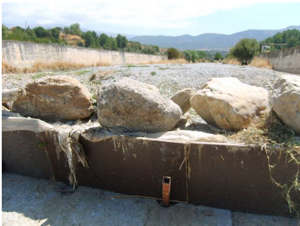
Presa de Alhacafa con el pueblo de Dilar al fondo. Aún después de haber hecho una presa de obra, se requiere taponarla al modo artesanal.
