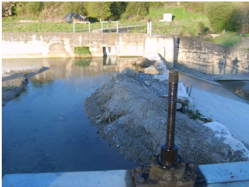
Segunda presa. Es la presa de Alhacafa que recoge el agua de las acequias de Alhendín y Otura (bajan desde lo alto del tajo salvando un acusado desnivel de 30 m).
