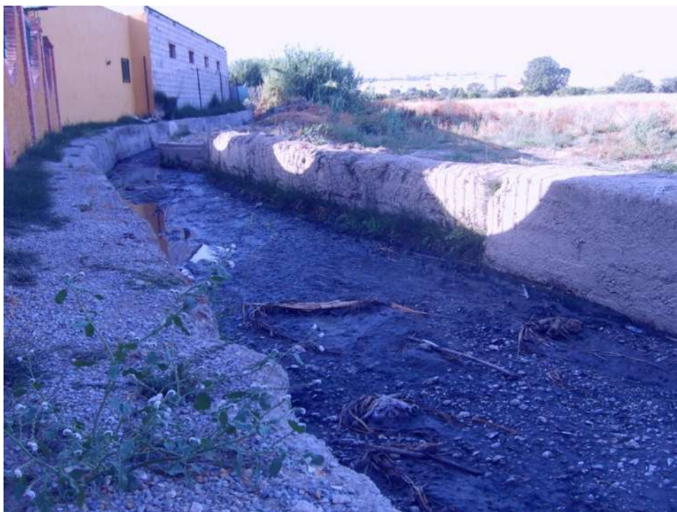
El Barranco Hondo en su tramo final de conexión con la acequia del Jueves.
