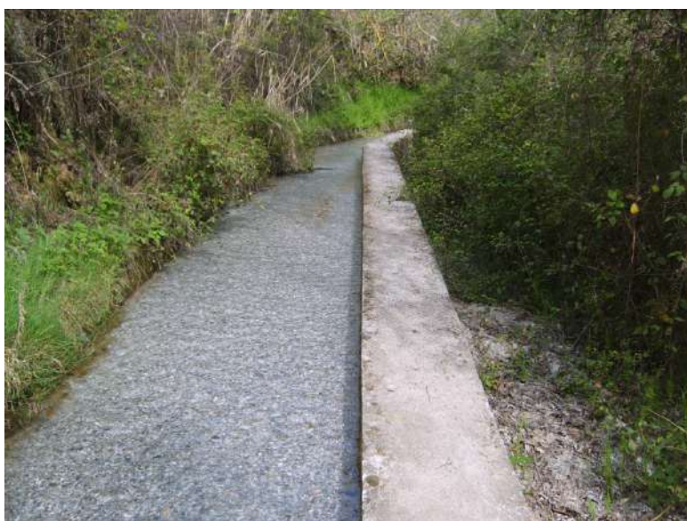
Gran cantidad de arena acumulada en el cauce de la Acequia de Otura.
