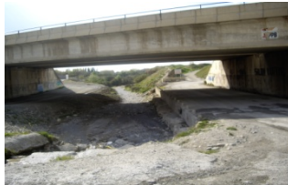
Puente de la autovía.
